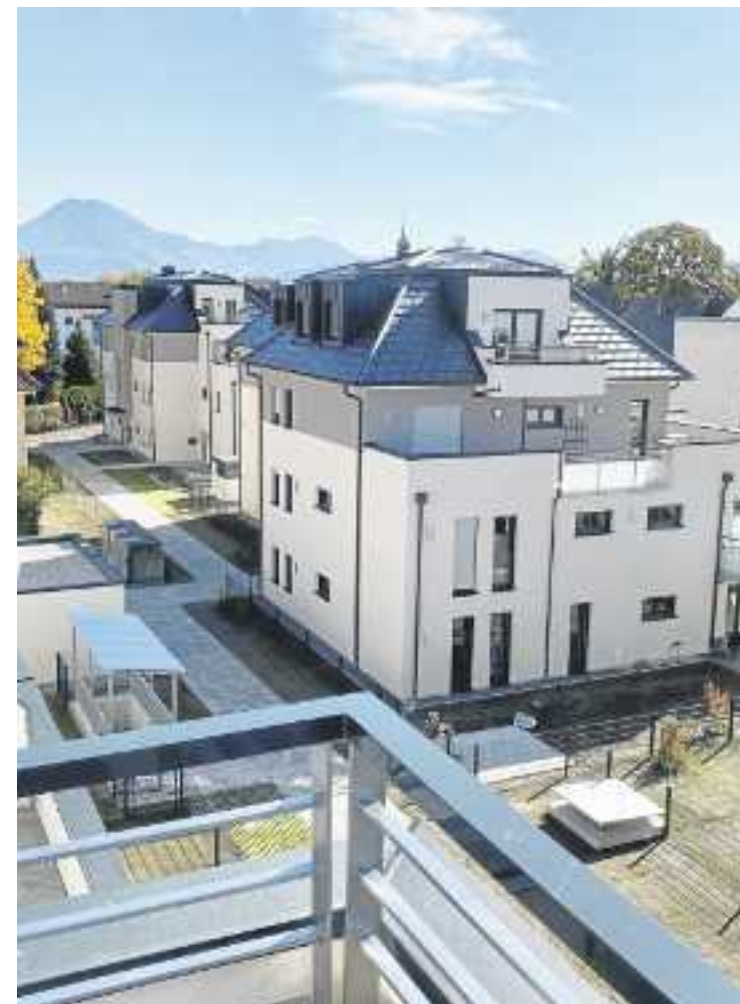
Blick über die Wohnanlage Richtung Altes Feuerhaus und den Gaisberg.
