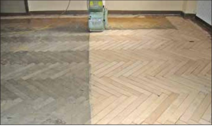
„Aus Alt mach Neu“ ist ein weiteres Leistungselement. Durch Abschleifen und Versiegeln bzw. Ölen erstrahlen alte, abgenutzte Parkettböden in neuem Glanz.
